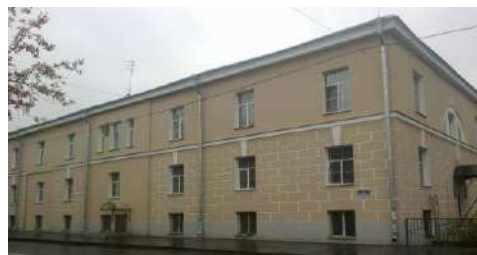
Отель под реставрацию (ОКН), Пушкин, ЛО (ГБА 4,8 тыс. кв. м)
