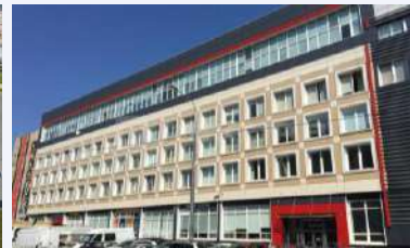
БЦ «Терминал», Санкт-Петербург (ГБА 15,5 тыс. кв. м)
