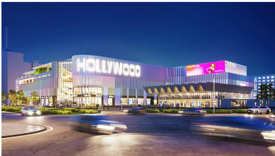
Крупнейший строящийся молл в Санкт-Петербурге – МФТПК HOLLYWOOD
